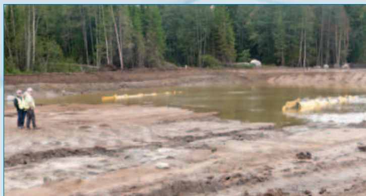
Начало Nord Stream под Выборгом
