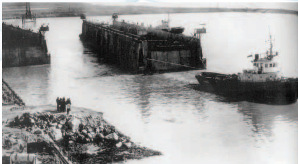
Строительство водопропускного сооружения
