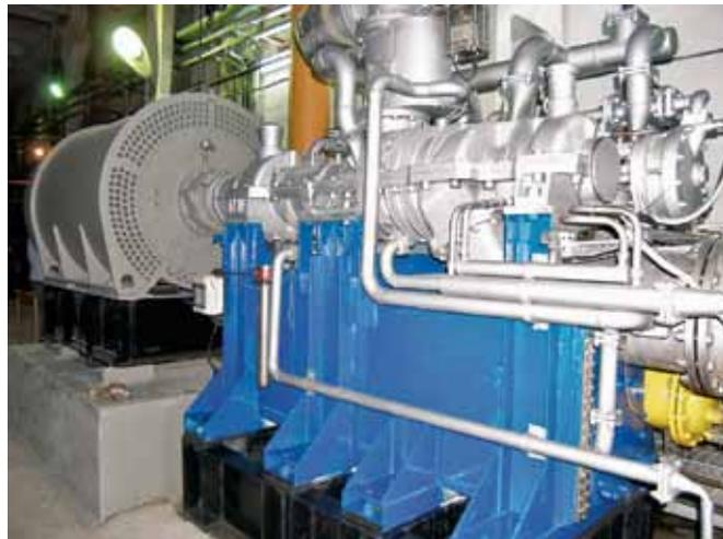
Энергетические агрегаты «ПВМ» имеют 100% заводскую готовность, смонтированы на блок-раме, имеют моторесурс 60 000 часов до капитального ремонта с возможностью продления, просты в монтаже и эксплуатации, ремонтпригодны за счет отсутствия сложных узлов и агрегатов. По сравнению с классическими лопаточными турбинами аналогичной мощности 1 МВт агрегат «ПВМ» имеет высокий КПД (70%), малые габариты и массу, при установке в котельной не требует капитального строительства.
