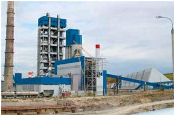
Реконструкции подвергаются заводы ОАО «Новоросцемент». Ведется строительство новой технологической линии сухого способа производства, производительностью 2 млн тонн цемента в год с использованием оборудования компании KHD Humboldt Wedag. Для реконструкции завода «Пролетарий» выполняется проект строительства новой мощной линии сухого способа на оборудовании компании FL Smidth (Дания).
