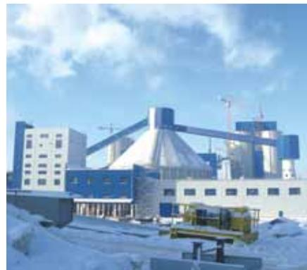
Разрабатываются проекты реконструкции заводов, входящих в состав ОАО «Новоросцемент». На заводе «Первомайский» этого объединения ведется строительство новой технологической линии сухого способа производства производительностью 2 млн т цемента в год, а также проектирование еще одной новой технологической линии.
