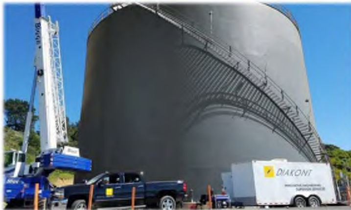
Нефтяные резервуары «Pascagoula» Миссисипи, США
